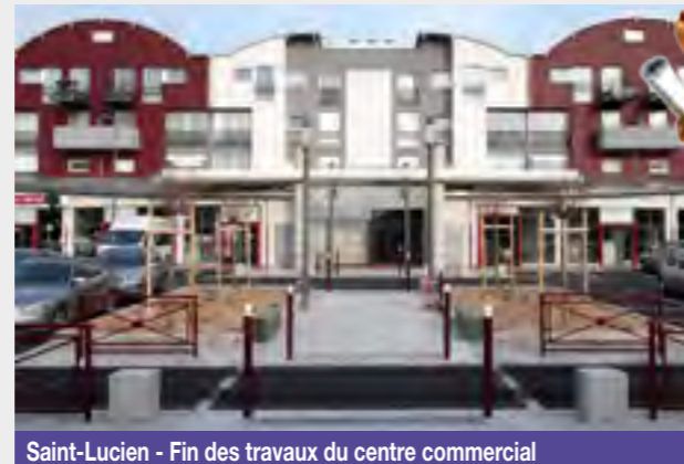
Saint-Lucien - Fin des travaux du centre commercial
