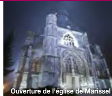
Ouverture de l'église de Marissel
