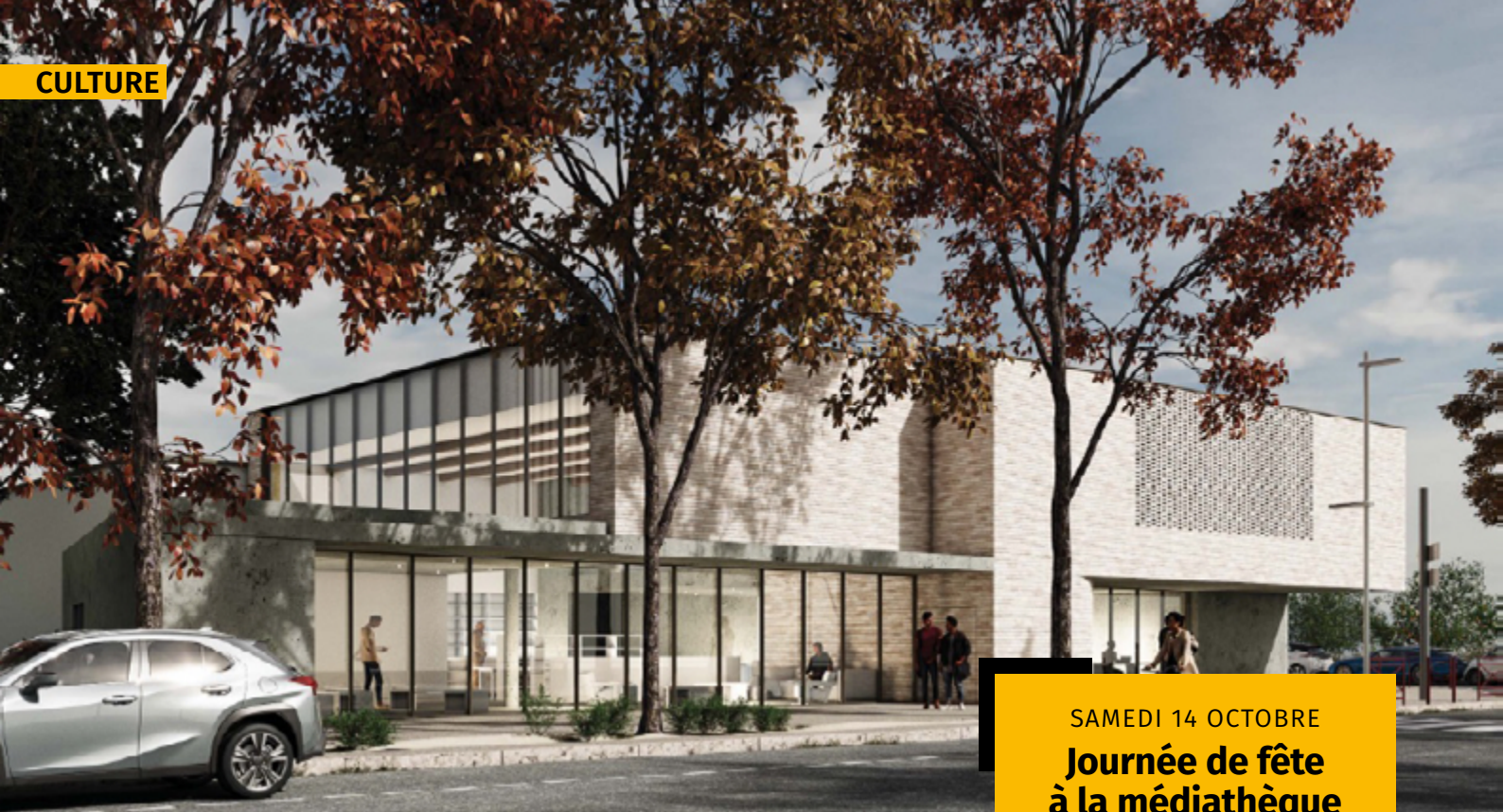
▲ Vue de la future médiathèque depuis l'avenue Jean Moulin. ©Continuo
